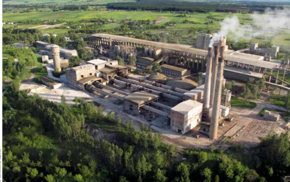
fot. Cementownia Rejowiec
